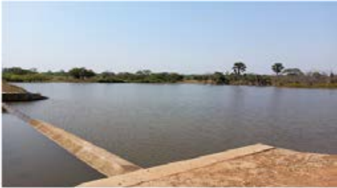
Bassin de rétention d'eau de surface de Bonwobérou
