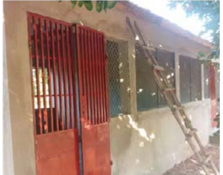
Poulailler en chantier à Ténonrou
