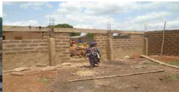
Photo 22 : chantier de construction du magasin de Gbégourou
