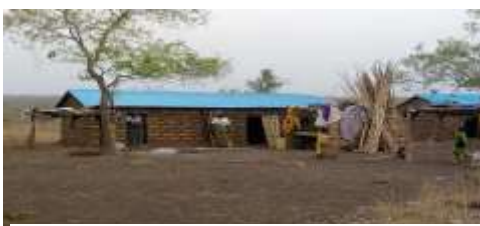
Photo 11 : Site des sinistrés reconstruit à Tilla - 2019
