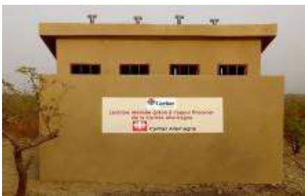
Photo 8 : Un des modules de latrines construit pour les sinistrés sur le site de Tilla, 2019
