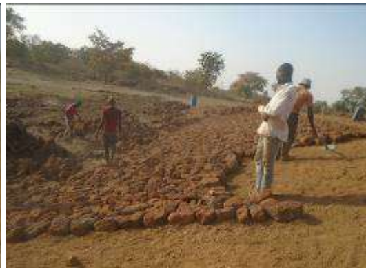
Photo 47 : Travaux de pose de moellons sur le talus amont de la digue de la retenue d'eau à Gbégorou, Archidiocèse de Parakou, 2020
