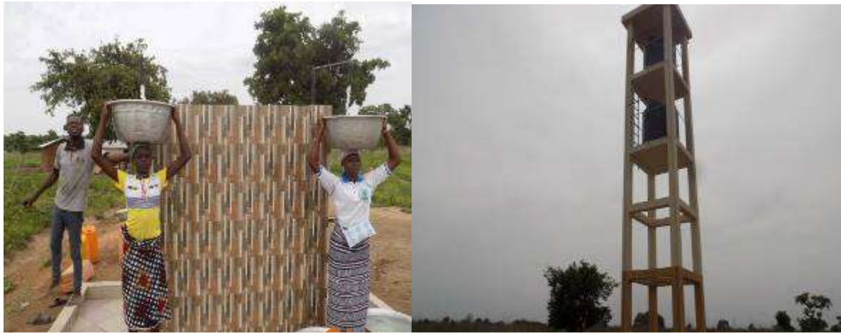
Photo 44 : Aperçu de l'ouvrage d'approvisionnement en eau potable réalisé dans le village de Yenkou, Pèrèrè, 2020
