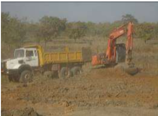
Photo 46 : Gerbage et chargement d'argile pour le remblai compacté de la digue à Gbégorou, Archidiocèse de Parakou, 2020
